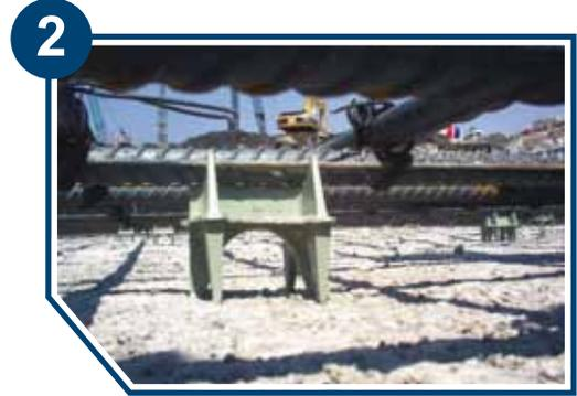
3. Las piezas deben quedar distribuidas de acuerdo a la forma o configuración de la estructura de refuerzo.
