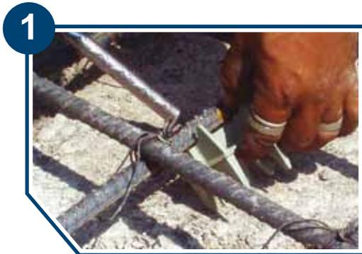
2. Es importante que las silletas estén distribuidas máximo 60 a 90 cm de distancia traslapándose, dependiendo del peso del armado del acero de refuerzo. Cada silleta tiene una capacidad de carga de 450 kg.
